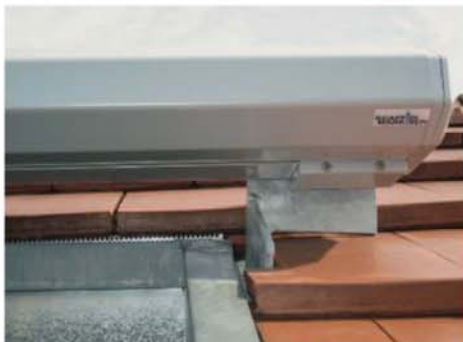
Erst wenn das Dach geöffnet ist, können die Dachkonsolen genau ausgemessen werden.
