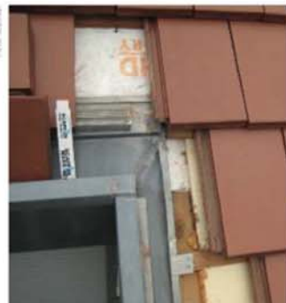
Erst wenn das Dach geöffnet ist, können die Dachkonsolen genau ausgemessen werden.
