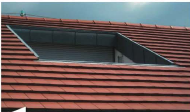
Die typische, im Dachbereich eingebundene Dachterrasse schafft je nach Dachschräge schnell ein Anbringungsproblem der Markise wegen einer zu geringen Höhe im Kopfbereich.
